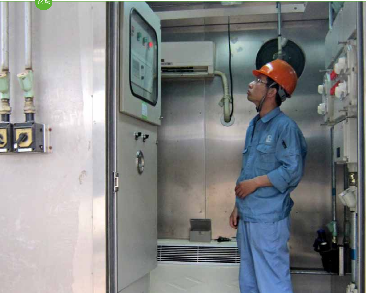
图1 基于 U23 分析仪的 CEMS 系统
