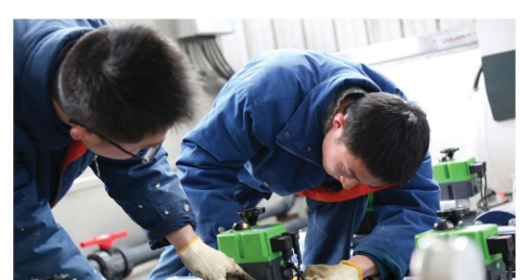
图片说明：黑虎山水厂工作人员蹲踞桌边调试投加系统检修
