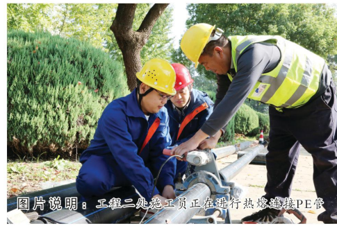
图片说明：工程二处施工正在进行热熔连接PE管
