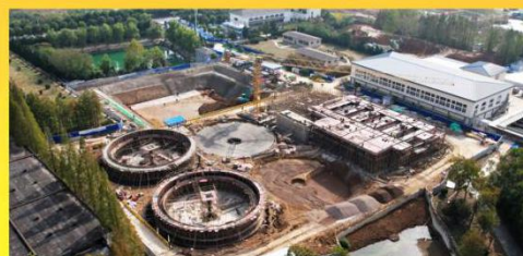
黑虎山水厂污泥干化项目建设
