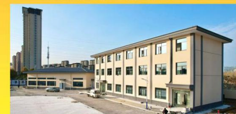
城西加压泵站工程建设
