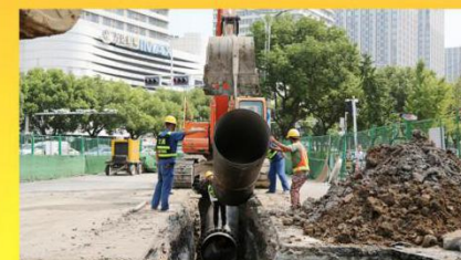
供水管网提升改造工程建设
